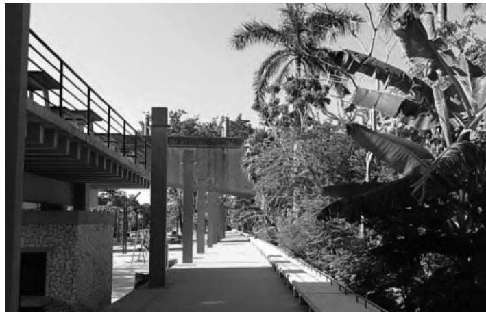
Figura 106. Malecón sobre el Río Grijalva. Sección Las Gaviotas
